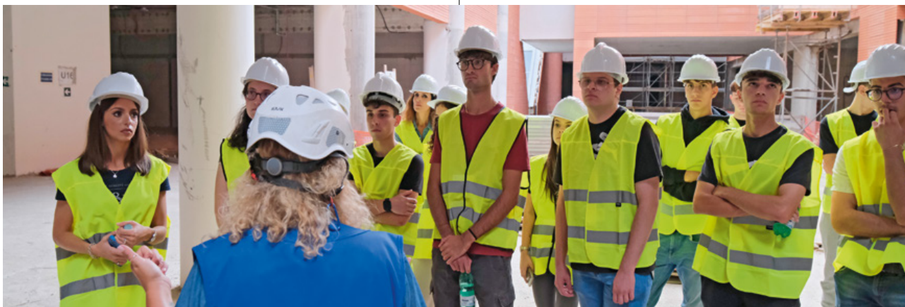
Cantiere del Policlinico Universitario di Caserta - visita guidata per i ragazzi del I corso per Geometri di Condotte 1880 Academy
