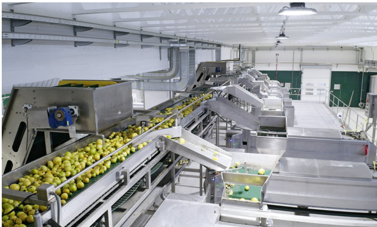
Il processo di lavorazione degli agrumi all'interno del sito industriale
