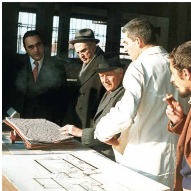
I Cavalieri del Lavoro Antonio Lamaro e Silvano Toti al cantiere di costruzione del Collegio Universitario "Lamaro Pozzani" all'inizio degli anni Settanta
