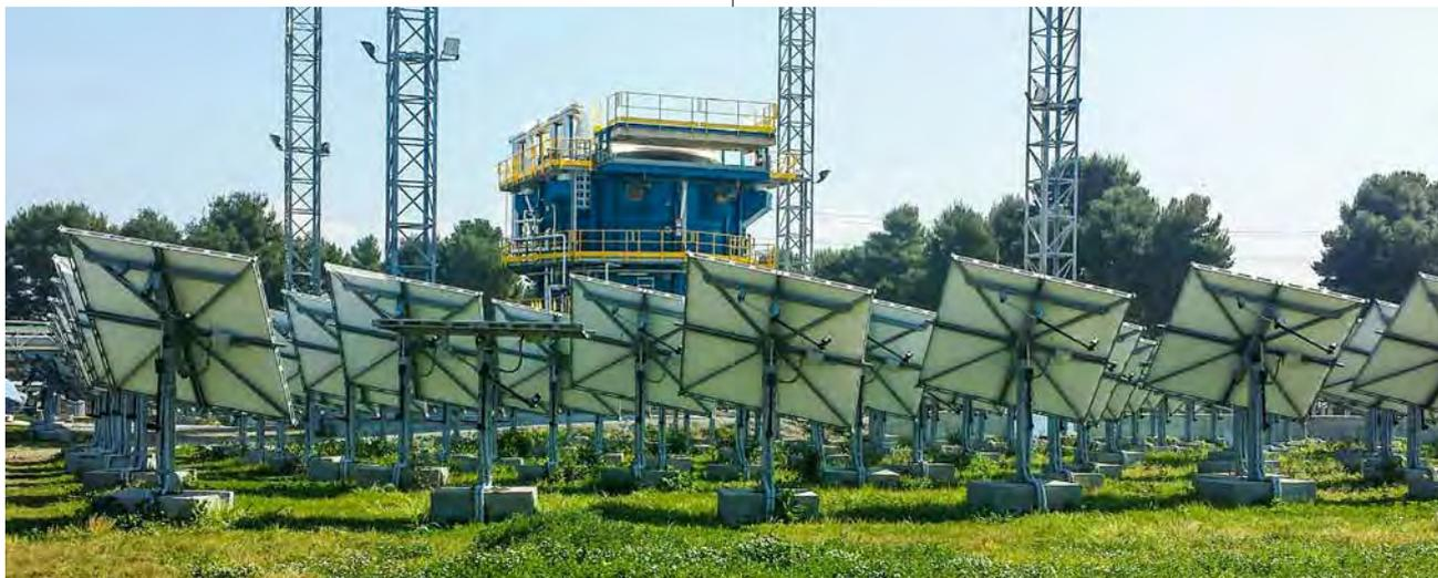
*Impianto sperimentale Magaldi STEM®-CSP per produrre dalla radiazione solare concentrata vapore surriscaldato 24 ore*
