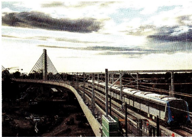
Sydney Metro Northwest . Una delle opere realizzate da Webuild in Australia
