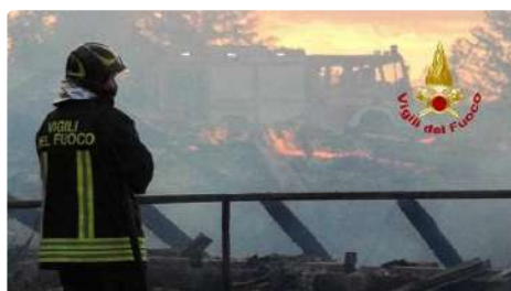
Santa Vittoria in Matenano, incendio durante la notte a struttura ex piscina. Crolli e gravi danni mer 02 giugno • Cronaca
