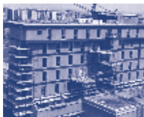
Il cantiere, primi anni '70
