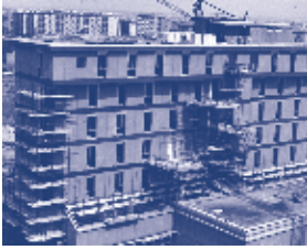
Il cantiere, primi anni '70
