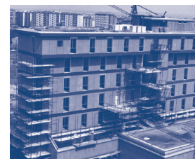
Il cantiere, primi anni '70
