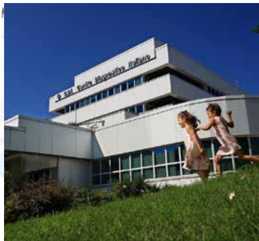
La sede centrale di via Saint Bon
