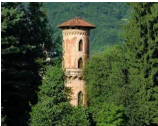
La torre del Castello di Miradolo, sede della Fondazione Cosso
